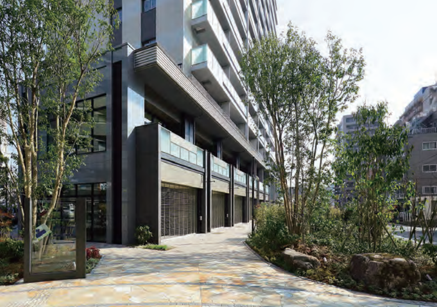
商店街の動線がスムーズになっている店舗前の広場
