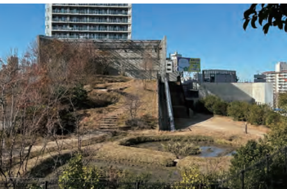
オオタカが飛来した首都高速道路大橋ジャンクション換気所屋上に整備された水田などの緑地「おおはしりの杜」
