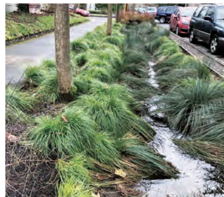
雨水貯留・浸透機能を果たす掘り込みの植栽帯(ポートランド市ホームページより)
