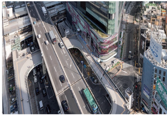
Shibuya Sakura Stage（中央上の桜色建物）と共に整備された歩道橋（首都高の下）の下のと渋谷区道（右斜めの道）は桜丘地区の回遊性と防災性向上に資する
