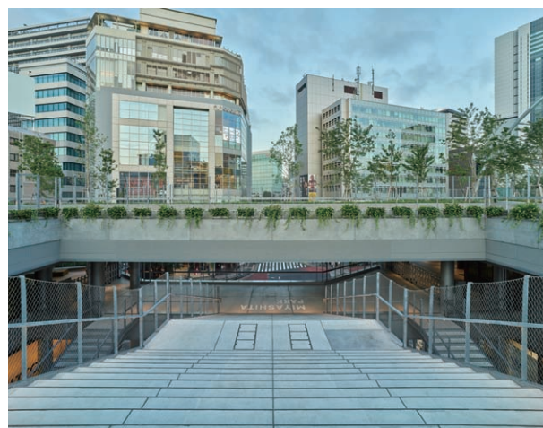
宮下公園と商業施設「RAYARD MIYASHITA PARK」を自然に繋げる大階段
