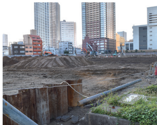
土壌汚染対策工事が行われている造幣局跡地
