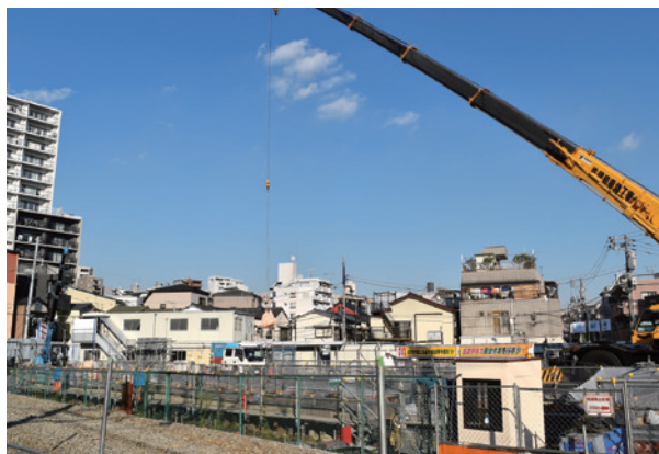
工事中の「東池袋五丁目地区第一種市街地再開発事業」の施行区域
