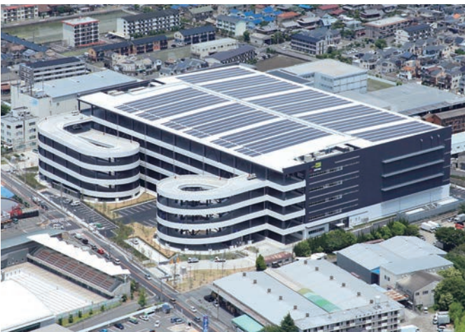
屋上部分に遮熱効果が見込める太陽光パネルを設置したランドポート高槻
